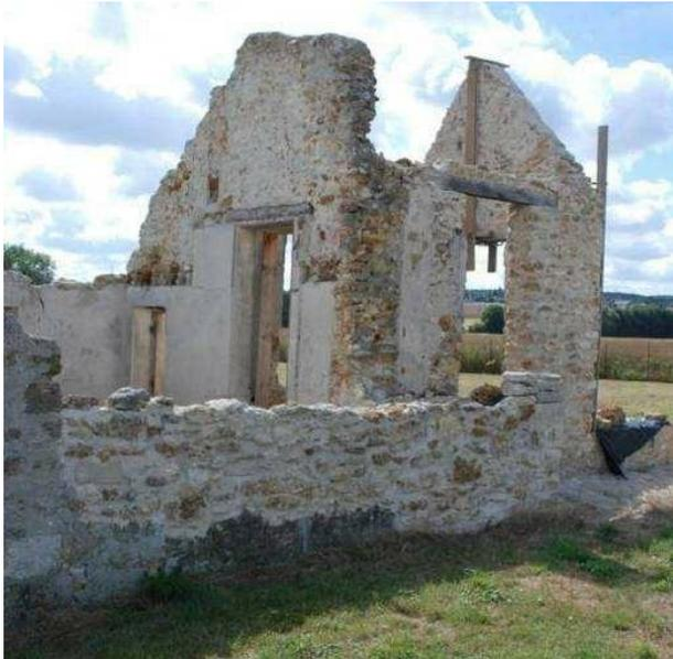
**2009** : après l'achèvement du pignon sud, il a été question de reconstruire les élévations dans la partie laiterie. L'objectif était de reconstruire le mur jusqu'au niveau de la panne sablière, ainsi que l'angle du mur et de reprendre le pignon entre la laiterie et la chapelle.
