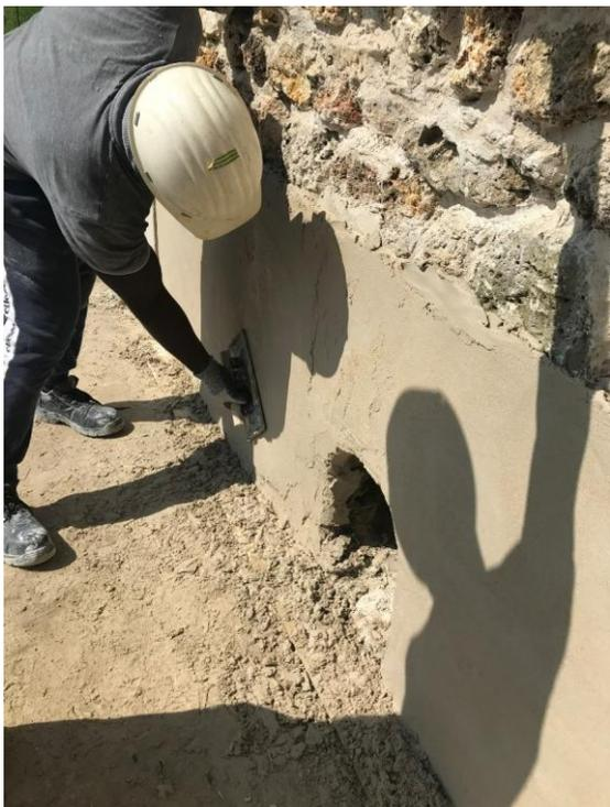
**Reprise du soubassement :** Les joints et les enduits restants ont été pictés et les pierres apparentes ont été brossées pour enlever mousses et terre. Un enduit de corps (renformis) a été ensuite réalisé pour reprendre la planéité, et des morceaux de tuiles ont été incrustés dans cet enduit sur les parties présentant un faux aplomb important. Le mortier utilisé est composé d'une part de chaux NHL5 et deux parts de sable à maçonnerie de granulométrie 0.2.
