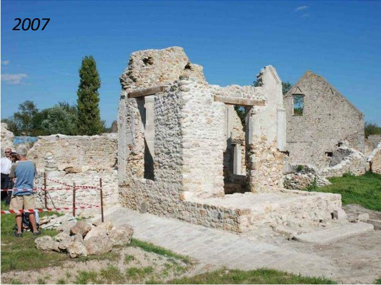
**2007** : remontage des maçonneries du gros œuvre (murs et pignons) + opération de stabilisation des maçonneries des bâtiments adjacents. Projection de mortier hydraulique
