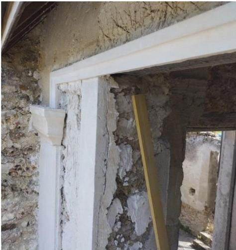
**Dressage des deux retours des pilastres** : collage et mise en place
