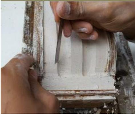
**Réalisation des chapiteaux et des consoles** : sur table, à partir des dessins effectués lors du stage de printemps et suite à la réalisation des calibres
