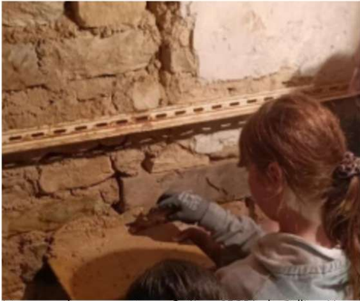
Jointoyage de murs en pierres © 4ème SEGPA du Collège Vivant Denon
