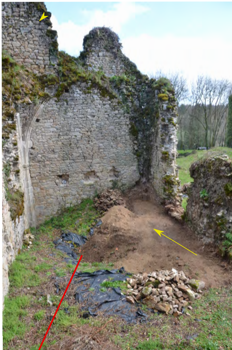
Ancienne fouille non autorisée
